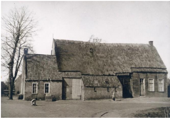
9. Dubbele Boerderij Hofstraat 1-3 Afgebroken. Hier is later de winkel van Nieman gebouwd en thans staat hier een appartementen complex op de hoek van de Raadhuisstraat - Hofstraat.
